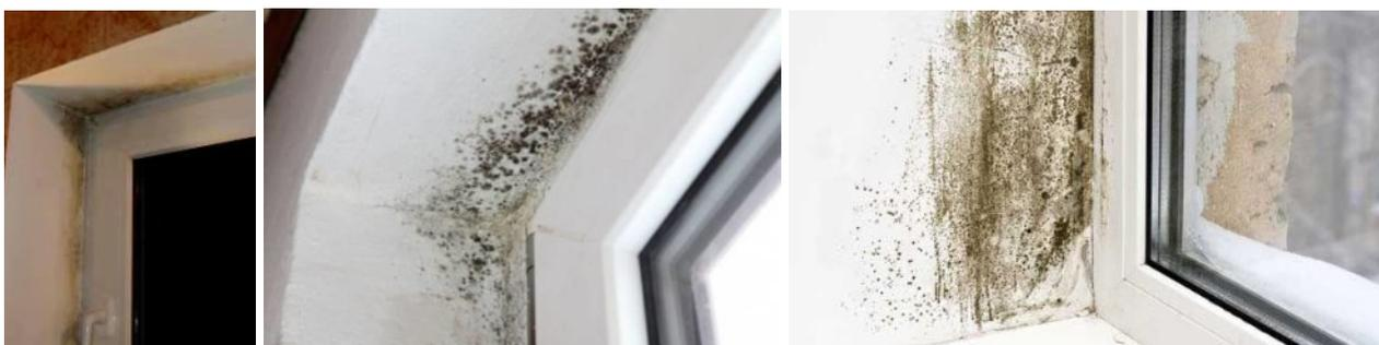
Figure 7 : Images de condensation et moisissure en périphérie de tableau de fenêtre (source : <http://www.ponts-thermiques.be/fr/theory/risques>)
