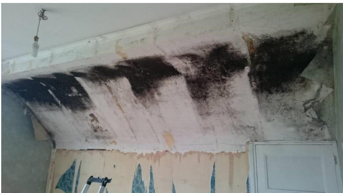
Figure 4 : Image d'une face intérieure de toiture avec pose d'ITI sans pare-vapeur (source MANASLU Ing.)
