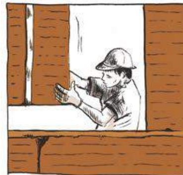
LES MODULES PRÉFABRIQUÉS SONT MIS EN PLACE AVEC UN MORTIER DE TERRE.
