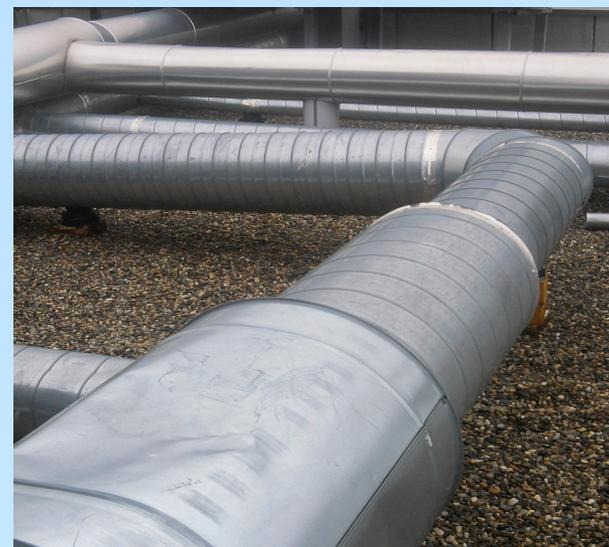
**L'absence de calorifuge à l'extraction fait chuter la température de l'air à l'entrée de l'échangeur, et réduit l'énergie récupérée, ce qui augmente la consommation de chauffage**
